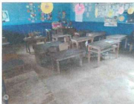
FOTO 3: FOTO DONDE MUESTRA AULA DE PAVULOS 1 Y 2 CON PISO RUSTICO
