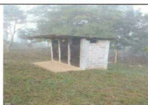
FOTO 6: BAÑOS DE PARVULOS
