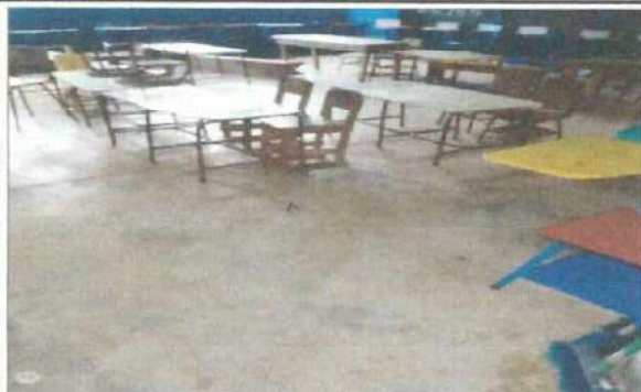
FOTO 1: AULA CON PISO RUSTICO
