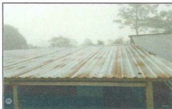
FOTO 3: LAMINAS OXIDADAS
