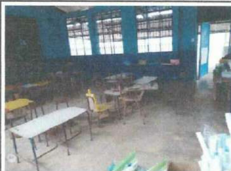
FOTO 2: AULA DEL MODULO 1, PISO SOLO ALISADO
