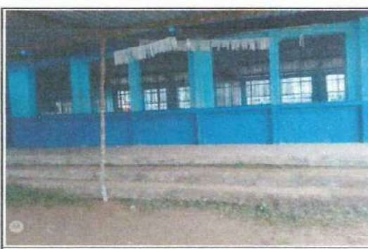
FOTO 6: GRADAS DESNIVELADAS Y EN MAL ESTADO
